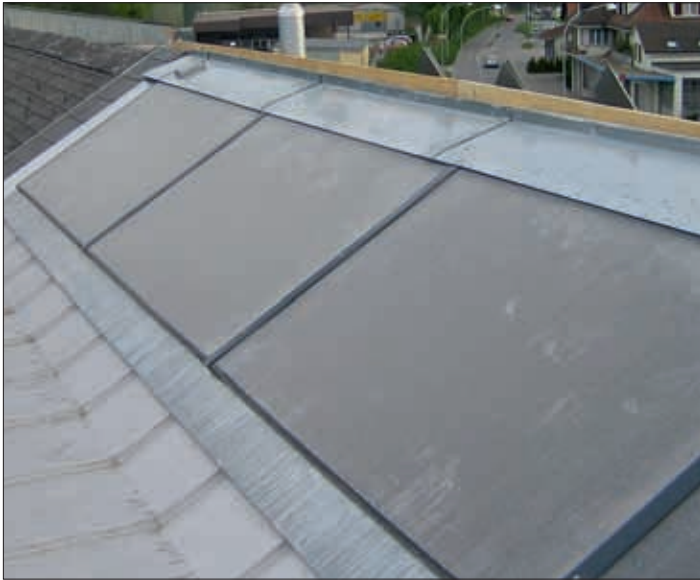
Installation von Solarpanels
