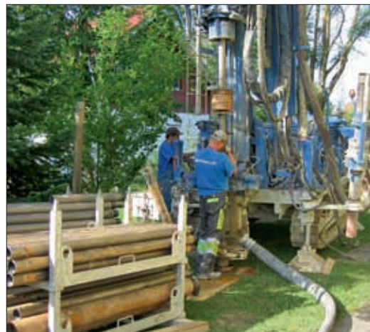
Bohrung auf 210 Meter
