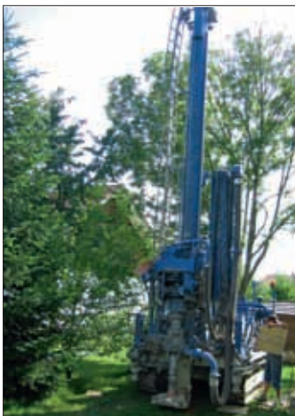
Geotherm Bohrmaschine im Einsatz
