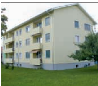
Fassadensanierung MFH Ins, 2011
