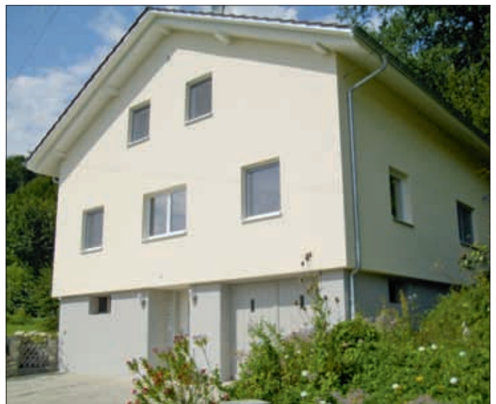
Fassadenisolation EFH Oltigen, 2011
